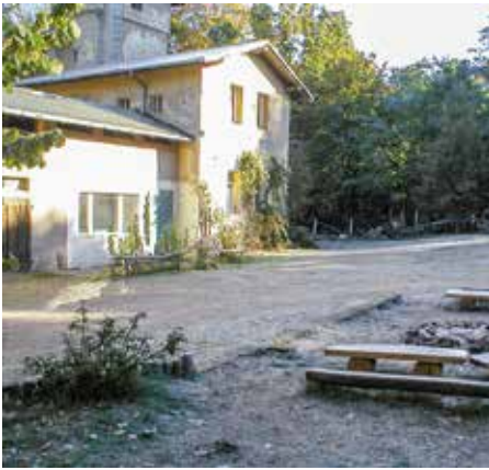
Waldschule, Wildmeisterei vor und nach der Renovierung
